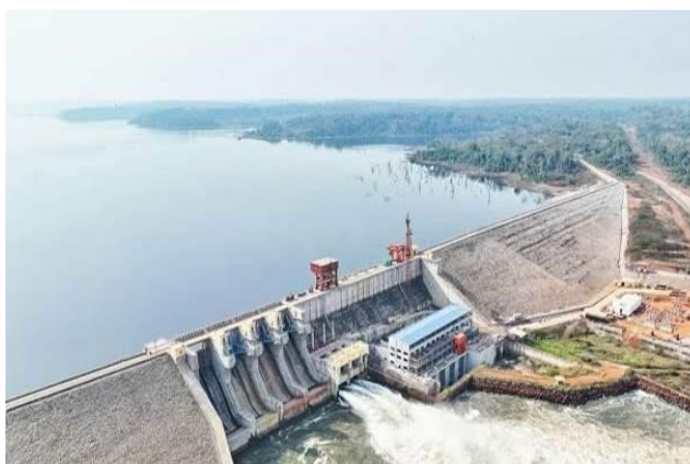
Vue du barrage de Lom Pangar
