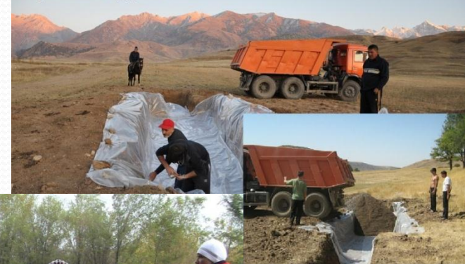
Строительство очистных сооружений для серой воды в с.Тонкерис и в лагере-кемпинге Дарбаза
