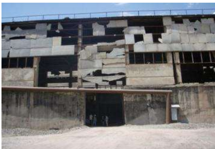
График0-1:Разрушение строения со значительным повреждением асбестовых плит
